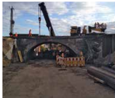
Die Gewölbebrücke in der Ziegelstraße Samstag, 29. April, ca. 18.00 Uhr vor Beginn der Arbeiten
