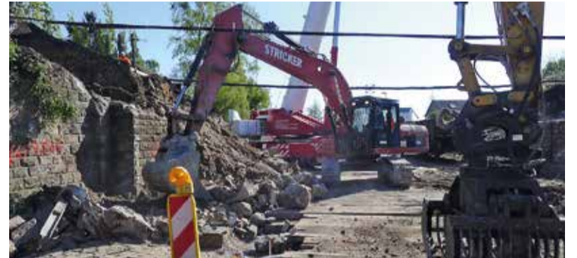
Davenstedter Straße, Sonntag, 30. April, 11.00 Uhr: Abbruch Widerlager
