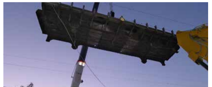
Ziegelstraße, Samstag, 29. April, ca. 21.00 Uhr. Ausheben des Überbaus, der ein Gewicht von 30 t hatte.
